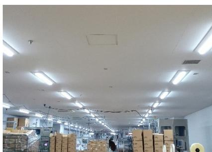
八王子工場で使用しているすべての照明をLEDに切替えました。これによって、消費電力が年間8.3%減少しました。また、CO2排出削減は年間29,386kg-CO2。換算係数は、削減電力(kwh)×0.555キログラム-CO2として算出)
